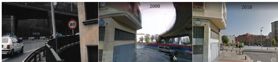
Ilustración 48: Edificio afectado del sector 23
