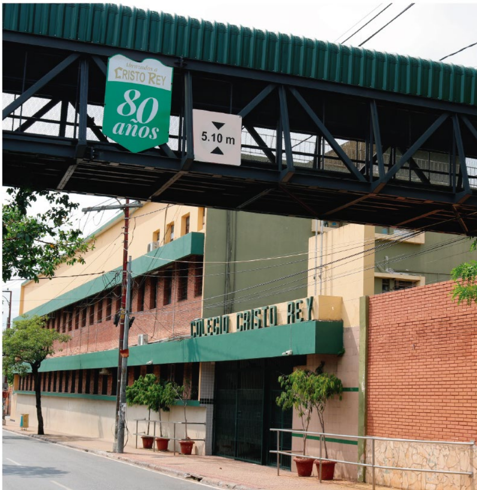
Figura 28: Fachada del Colegio Cristo Rey
