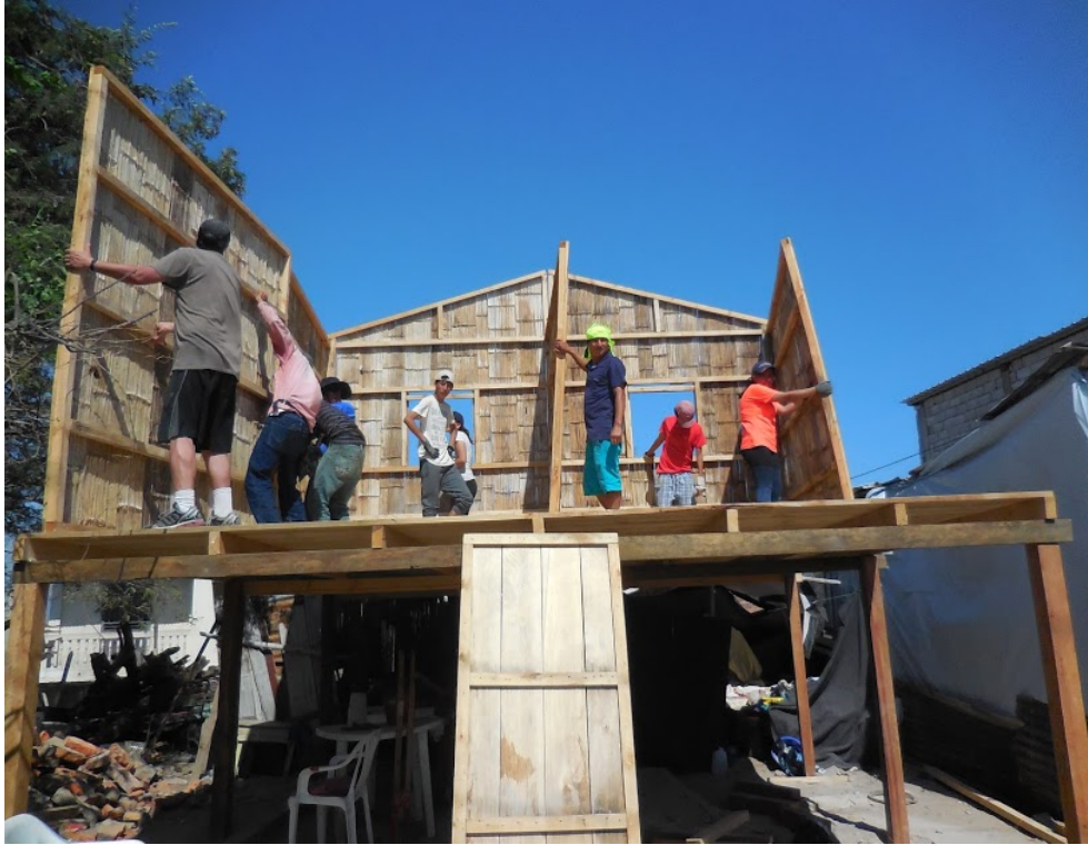
IMAGEN 20 CONSTRUCCIÓN DE CASAS EN MANTA
