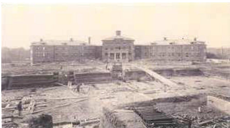
Imagen 1. Construcción de Cronsfill Hospital Center
