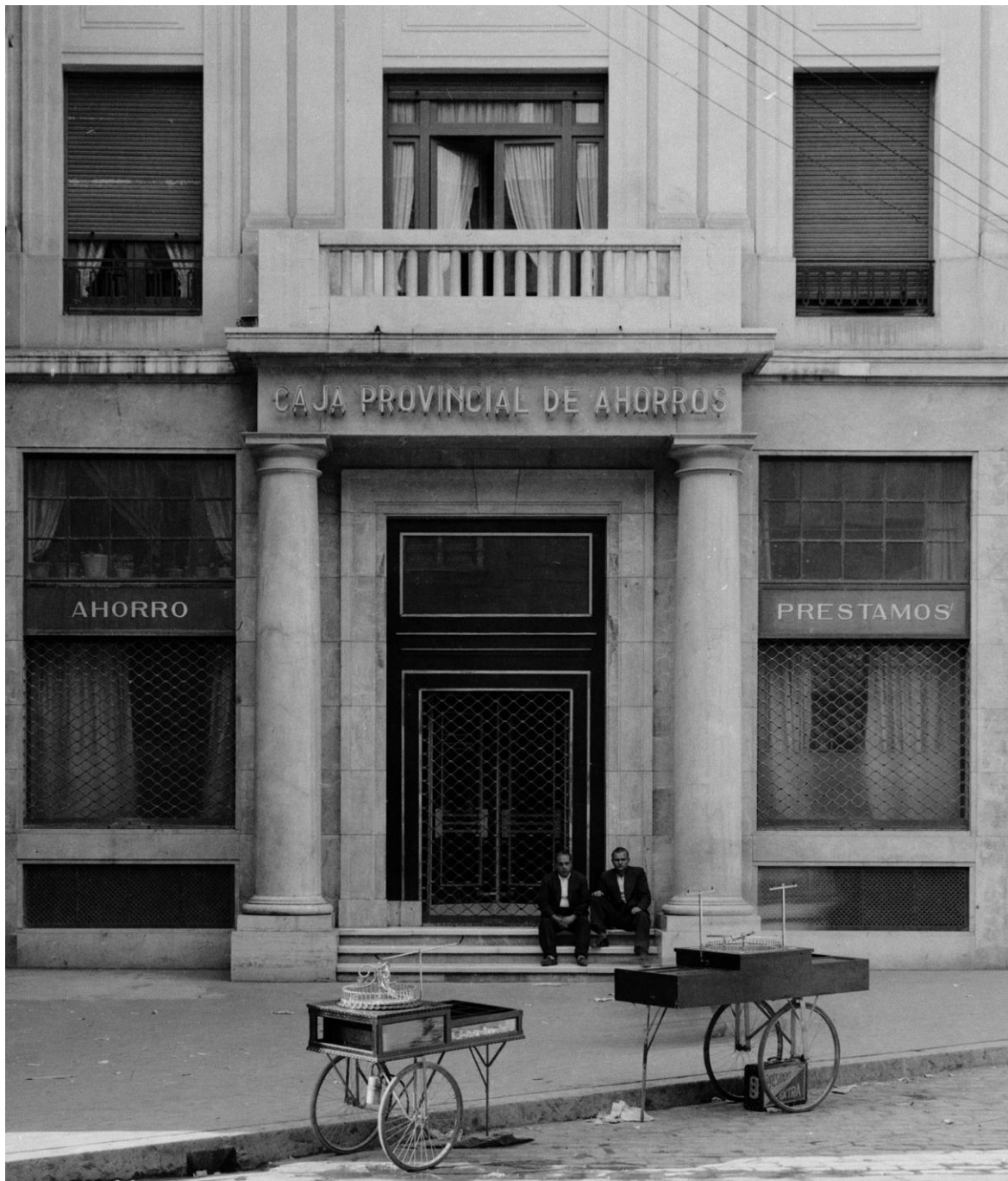
Nueva sede de la Caja Provincial de Ahorros en 1932. (Fig. 27)
