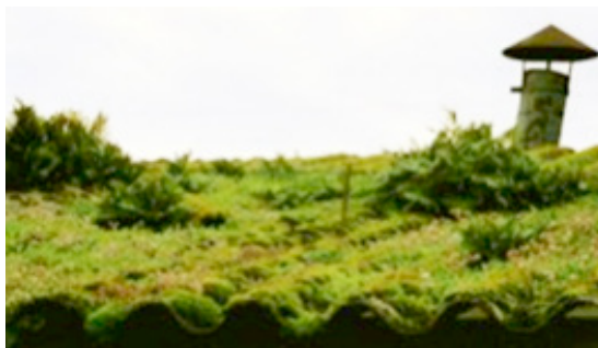
Figura 5.6: Tejado de una fábrica.
