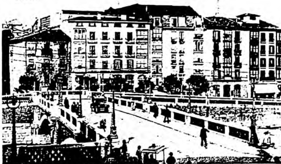
BILBAO. Puente de la Merced.
