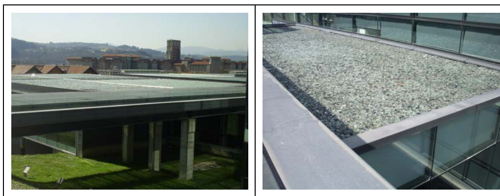
Figura 2.23 Gravilla de vidrio utilizada como aislante en un tejado.
